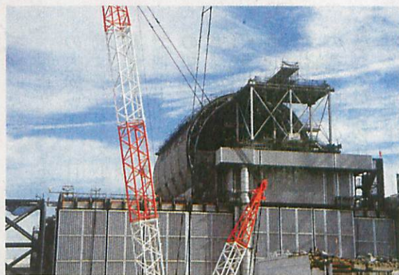
3号機では使用済み燃料の取り出しに向け、原子炉建屋上部にドーム屋根を設置中
