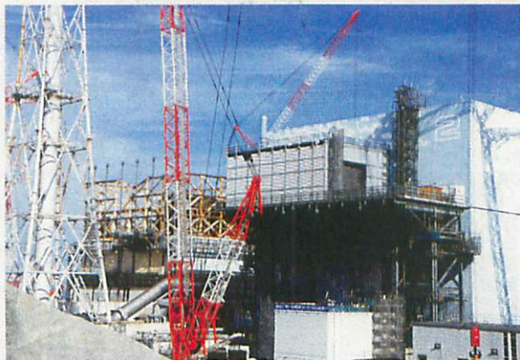
1号機（左奥）と2号機（右）では原子炉建屋のカバーを解体する作業が行われている Ryo Horiuchi
