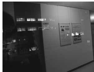
(a) 窓ガラス
