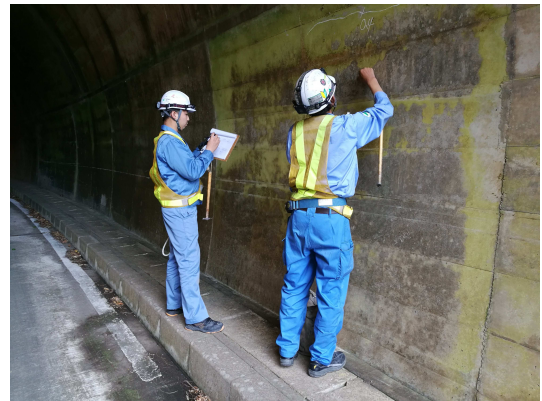
図1 点検員によるトンネルの点検作業
