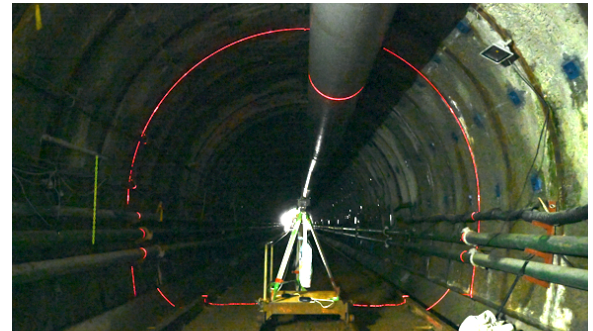
図4 トンネル断面の計測状況
