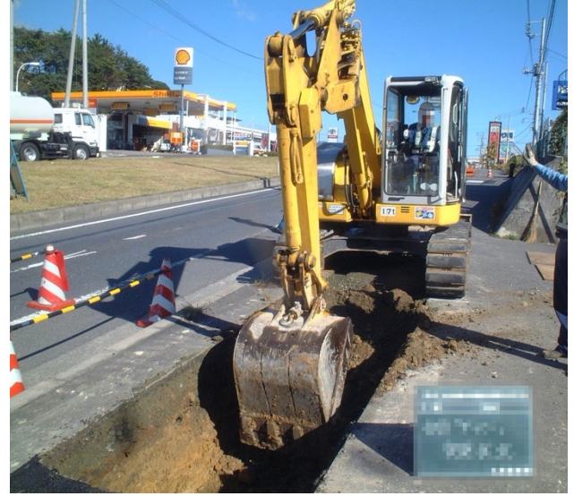
図1 都市での溝掘削
