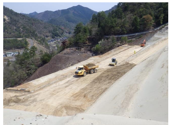
写真-2 盛土現場
