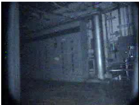
2号機原子炉建屋1階
