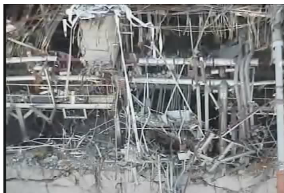
3号機西側より建屋内部
