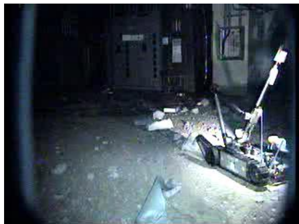
1号機原子炉建屋1階
