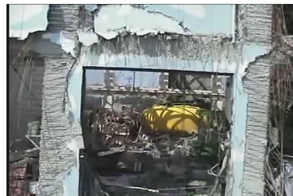
4号機東側より建屋内部
