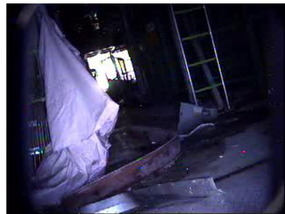
3号機原子炉建屋1階
