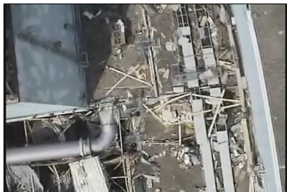
1号機南東角建屋カバー柱
