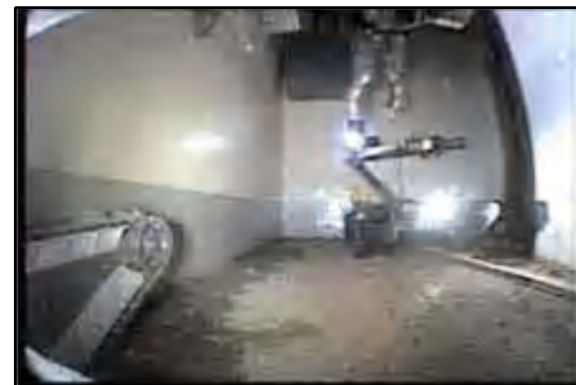
パックボットによる 原子炉建屋の現場確認
