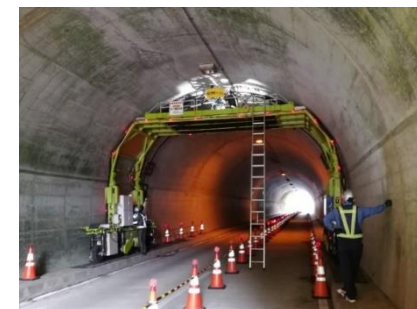
ロボットによる点検現場
