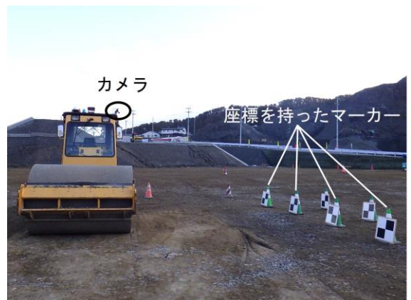
写真-2 マーカー設置状況
