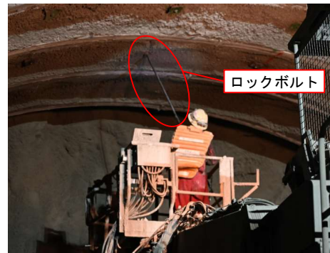
図1 ロックボルト打設の様子
